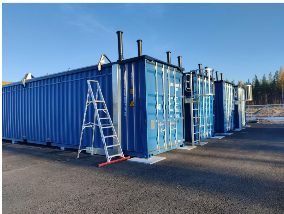
Kansikuva: Jätevesien esikäsittelylaitos valmistui ja otettiin käyttöön syksyllä 2024. Kuvannut Matti Leiviskä.
