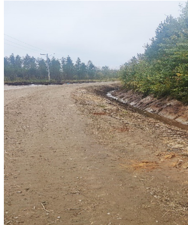
Kuva 4 Tien ravien kaivuuta
