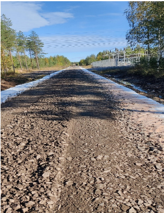
Kuva 5 Suodatin kankaan ja murskeen asennusta
