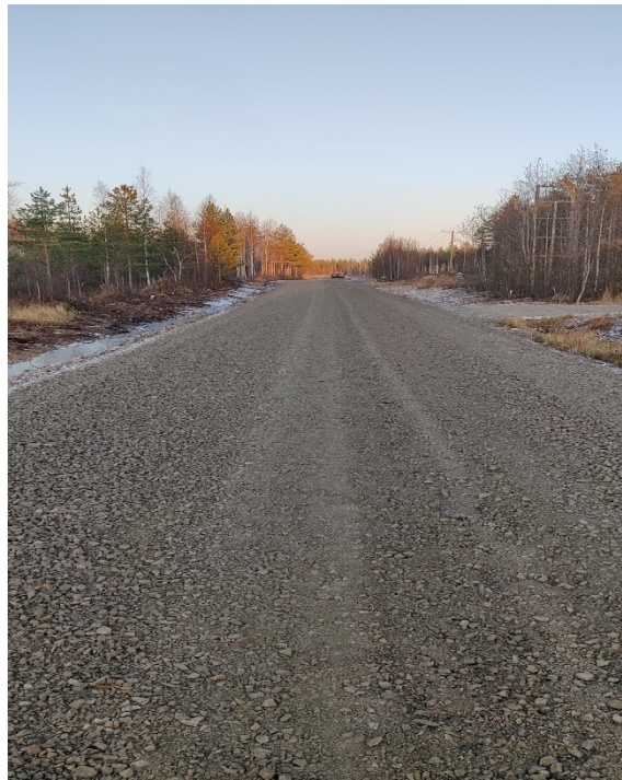
5010 Kuva 6 Murskeiden asennusta
