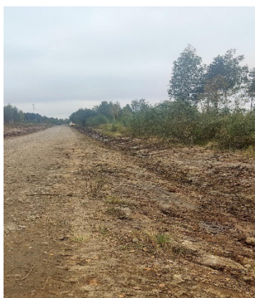
Kuva 2 Luiskien kaivuuta ja muotoilua
