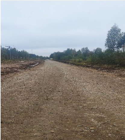
Kuva 3 Tien ravien kaivuuta
