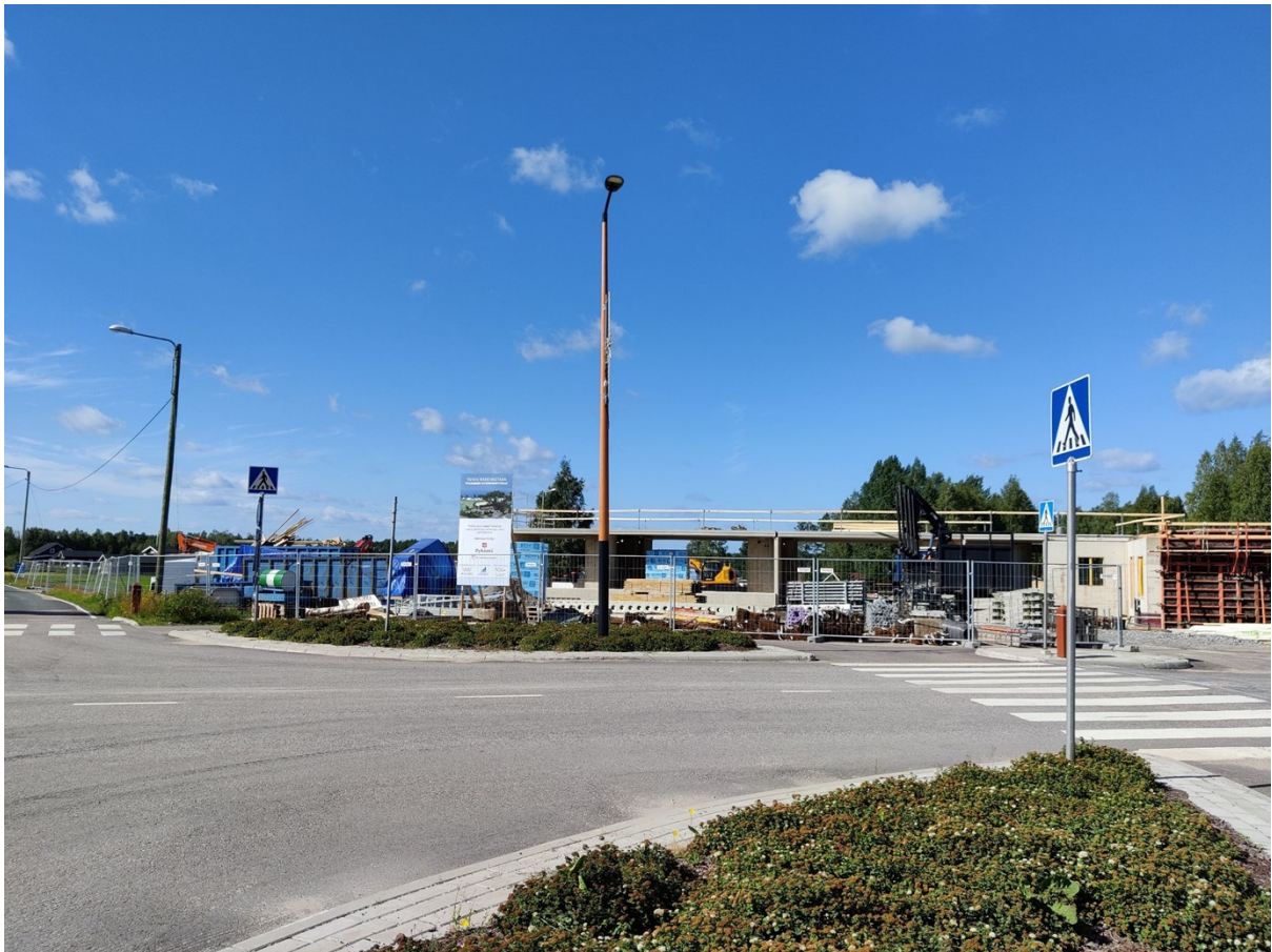
Kansikuva: Pyhännän hyvinvointitalon rakentaminen alkoi kesällä 2022. Kuvannut Matti Leiviskä.
